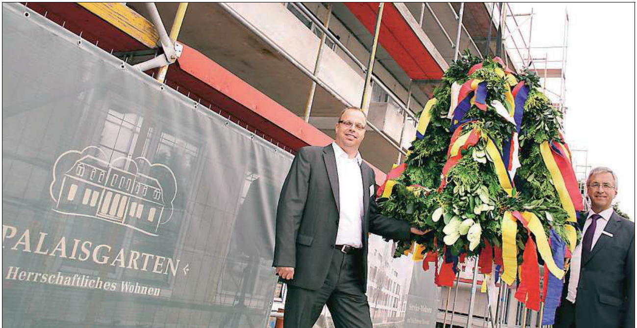
Baufortschritt im Wohnquartier Palaisgarten: Abalio-Geschäftsführer Matthias Decker (links) und OLB-Direktor Diedrich Kück präsentieren die Richtkronen, die seit Freitag über den ersten Stadtvillen hängt.
