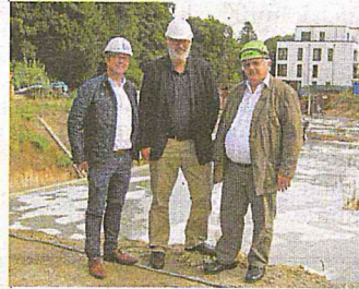
Bauleiter Stephan Lüsse, Bauherr Prof. Dr. Frank Stubben und Bauunternehmer Günter Hüls (v.l.n.r.) vor der Betondecke, auf welcher in den kommenden Monaten die vier Stadtvillen entstehen.
